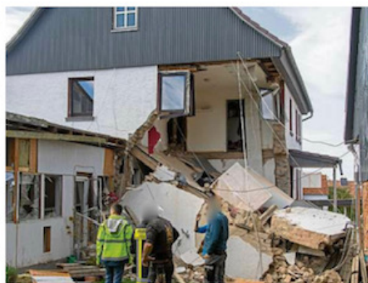
Eine Hausecke ist durch die Explosion abgebrochen.
